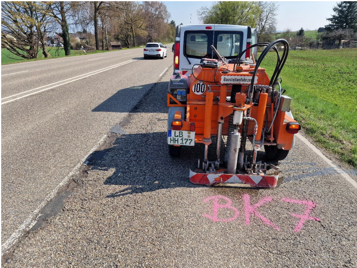
Foto Nr. 20: Entnahmestelle Bohrkern 7
