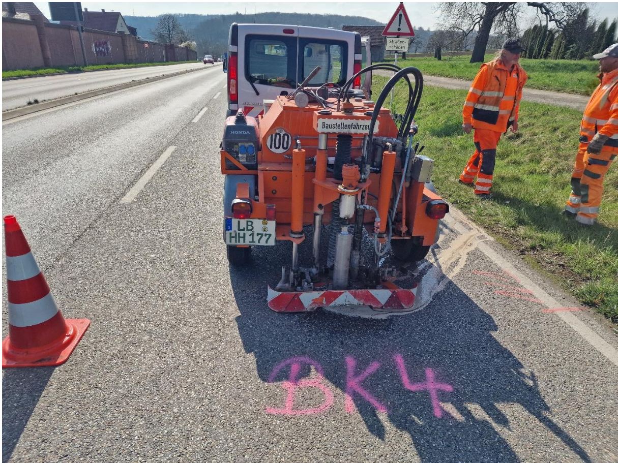
Foto Nr. 11: Entnahmestelle Bohrkern 4
