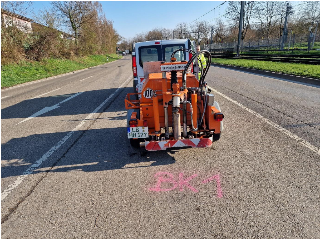
Foto Nr. 2: Entnahmestelle Bohrkern 1
